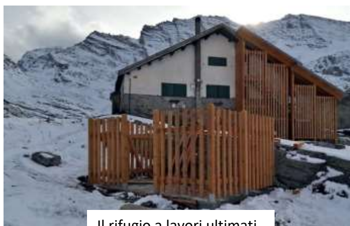
Il rifugio a lavori ultimati
